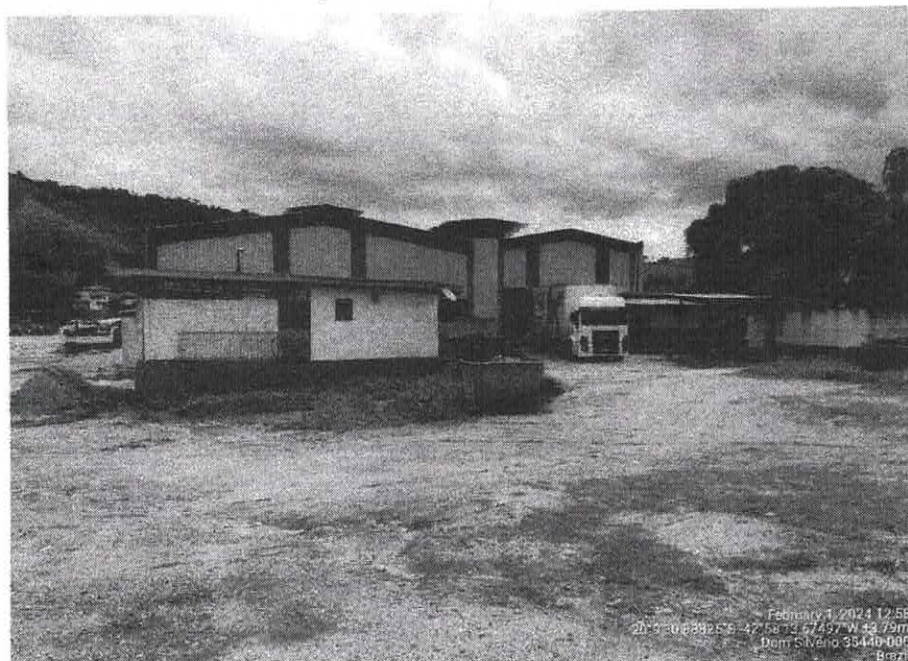
Figura 3 – Vista do imóvel
